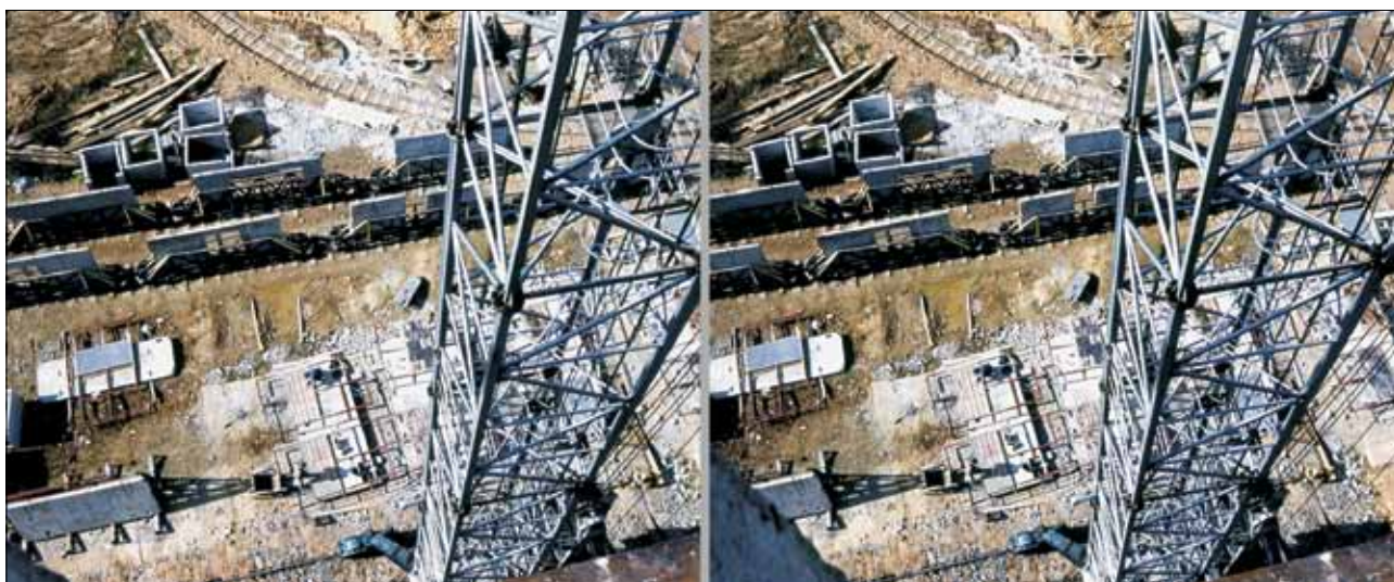
Budowa Winograd w Poznaniu
