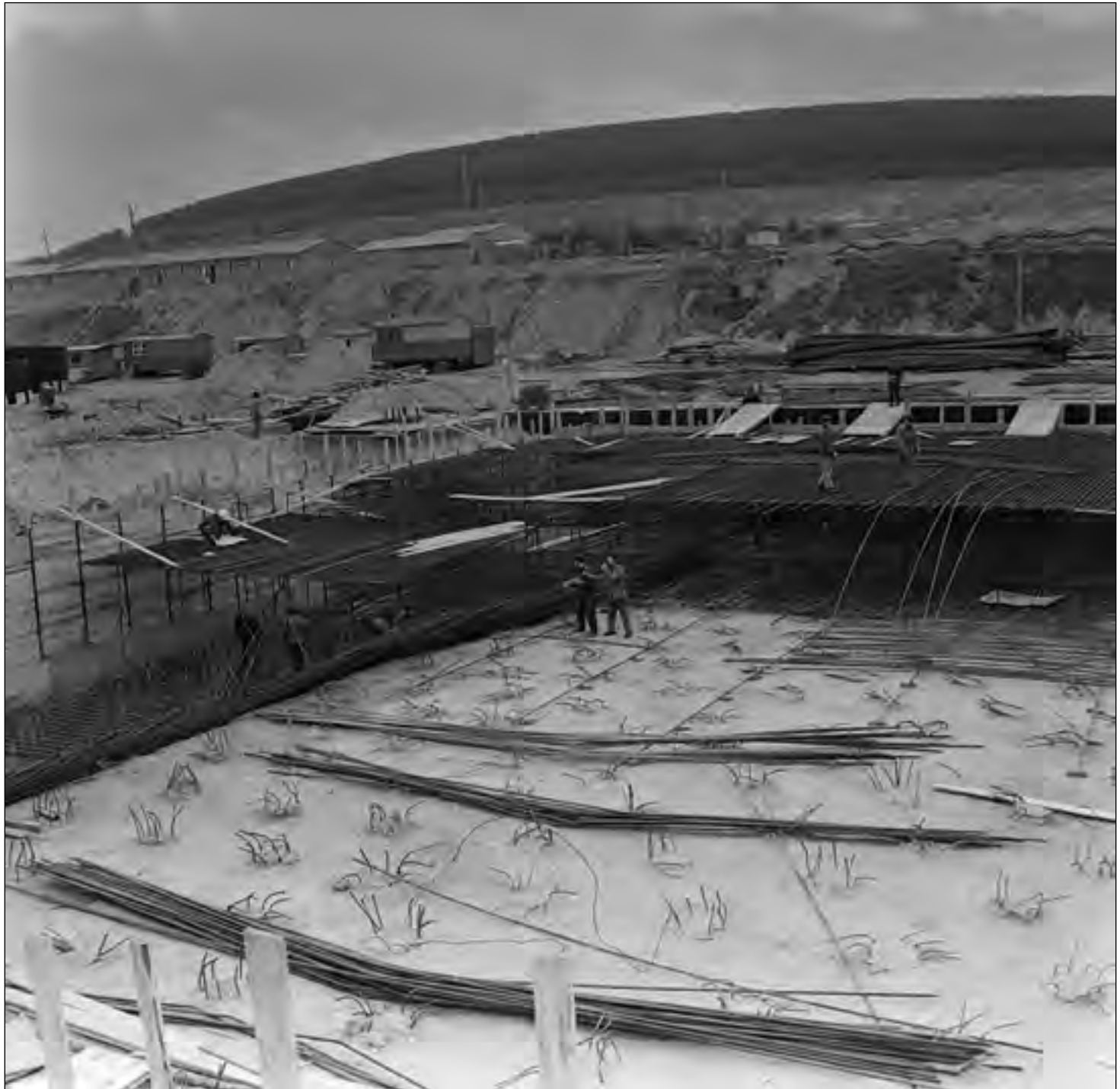
Janusz Stanisław Gajewski, Budowa Cementowni Nowiny II, 1972 r.
