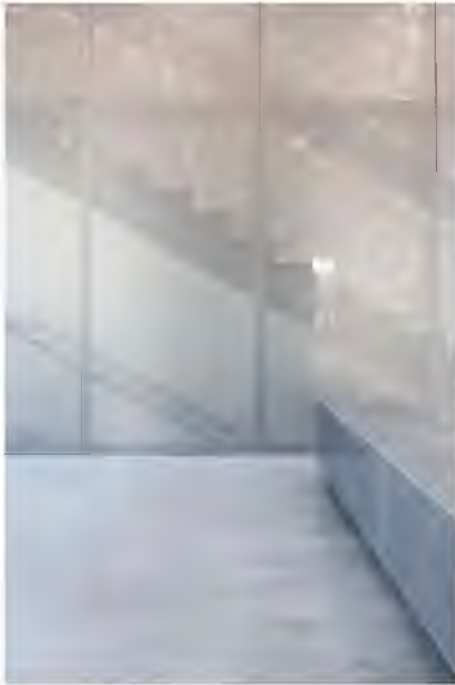
7. Fundacja Prada. Rem Koolhaas. Mediolan 2015. Fragment klatki schodowej wykończonej perforowaną blachą.
