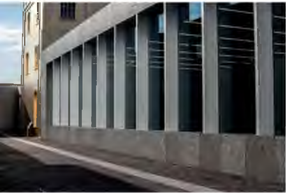
3. Fundacja Prada. Rem Koolhaas. Mediolan 2015. Podium. Panele ze spienionego aluminium w kontraście ze „złotą elewacją”.
